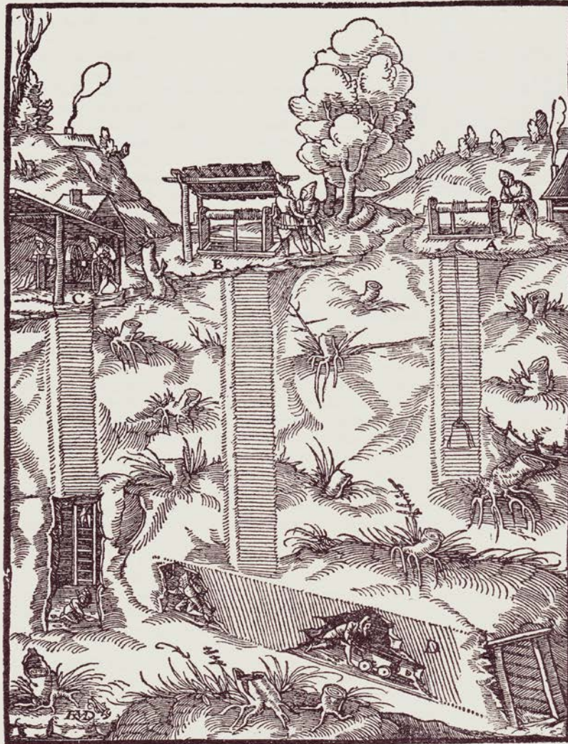
Drei säigere Schächte. Der erste Schacht, der noch nicht bis zum Stollen geteuft ist A. Der zweite Schacht, der den Stollen erreicht hat B. Der dritte Schacht, bis zu dem der Stollen noch nicht vorgetrieben ist C. Der Stollen D.
