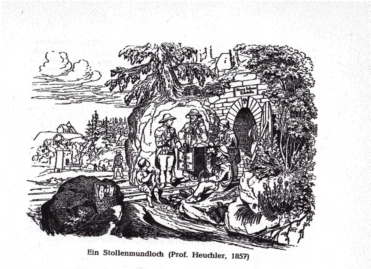
Ein Stollen ist für längere Zeit angelegt worden. Dies ist an dem aufwändig gebauten Stollenportal zu erkennen. Zur leichteren Förderung der gewonnenen Erze hat man für die Förderwagen Schienen verlegt.
